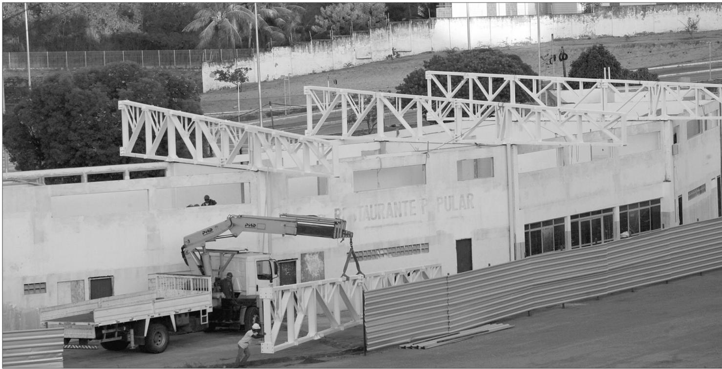
A fase atual da obra ainda é a de instalação das vigas de ferro para a cobertura do local, precisando fazer todo o acabamento, o que leva mais tempo
